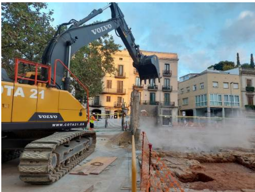
Foto 310: Eliminació de les porcions del mur 1003 que restaven.
