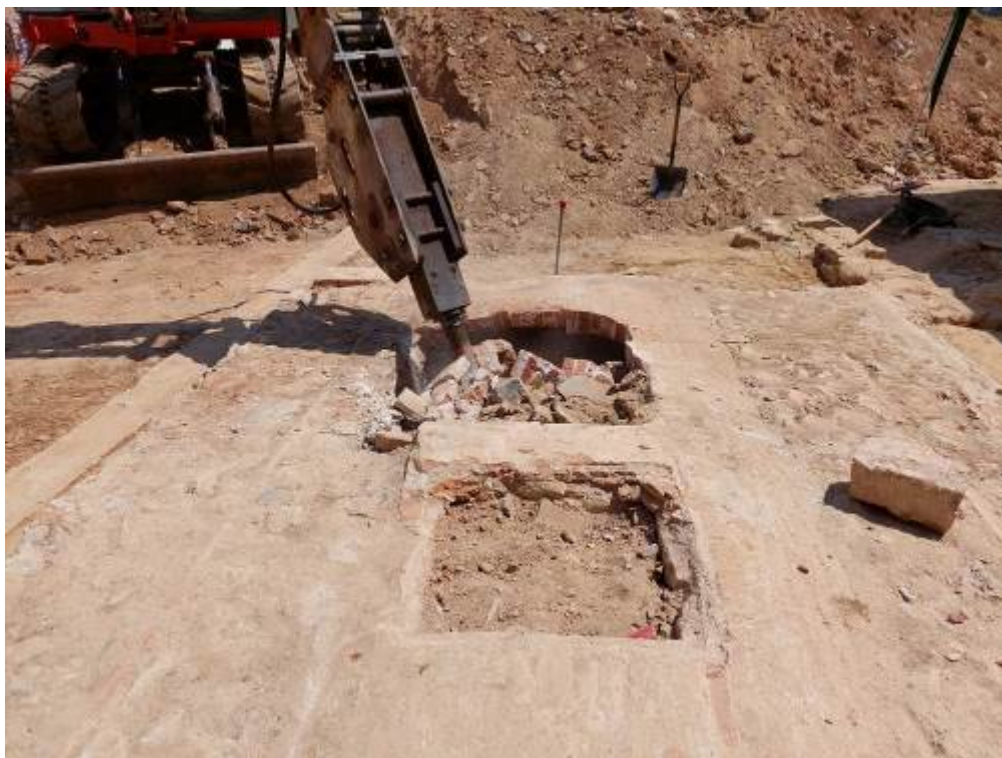
Foto 127: Eliminació controlada del registres dels cups 3003.
