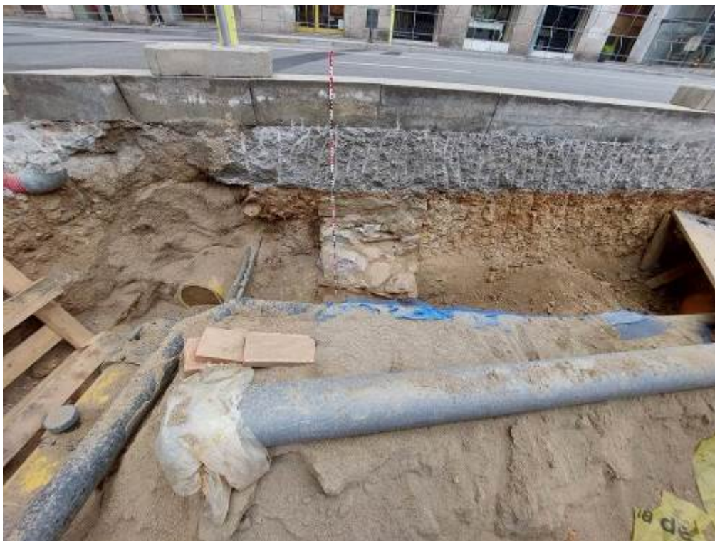
Foto 251: Estructura 3169 i rasa de gas 7058.
