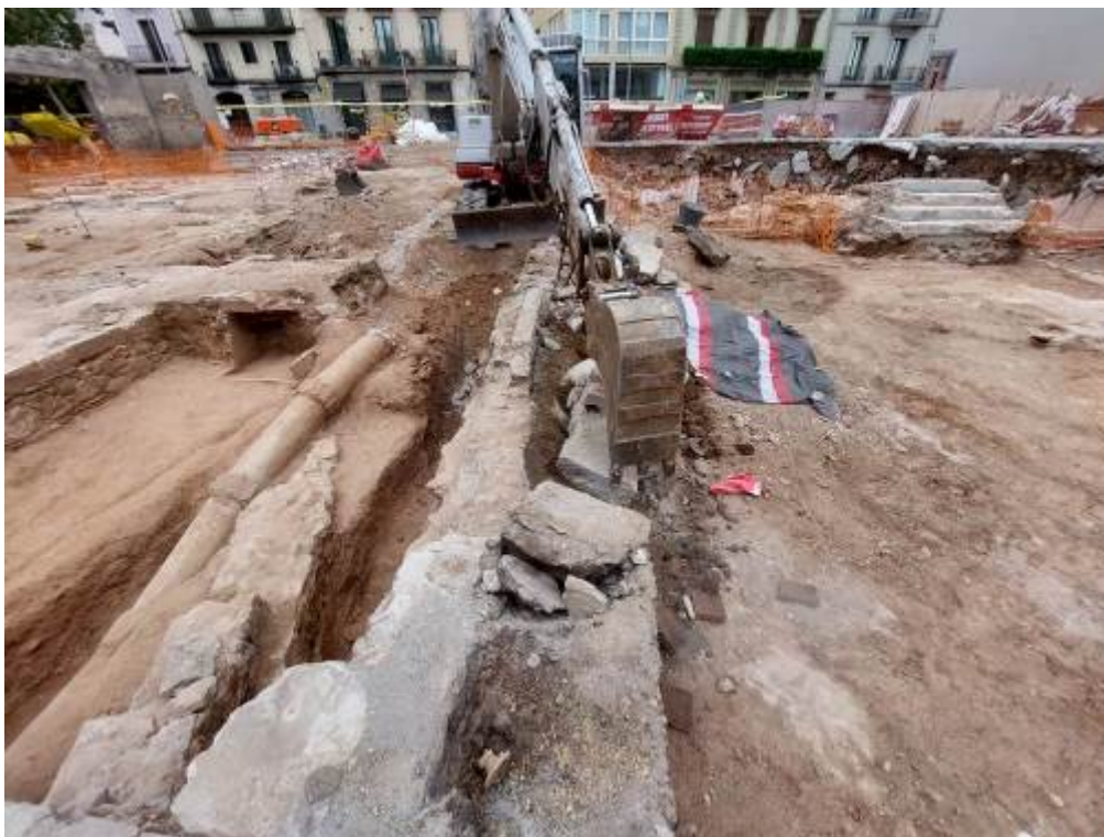
Foto 145: Eliminació controlada xarxa clavegueram 4002.
