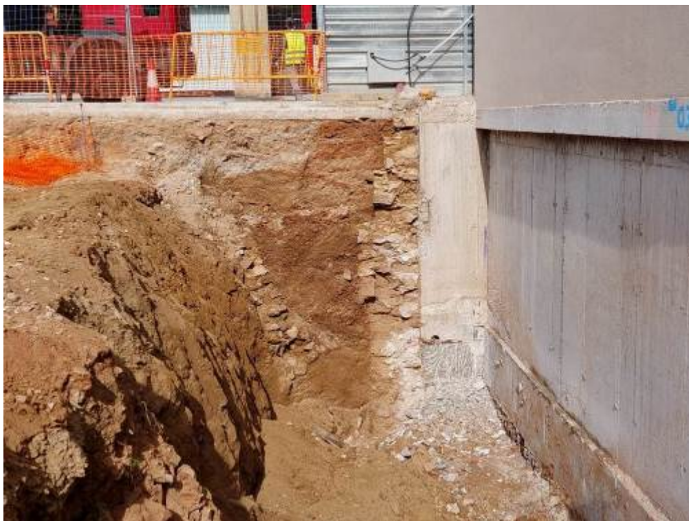
Foto 351: Eliminació murs 6021 i 6022.
