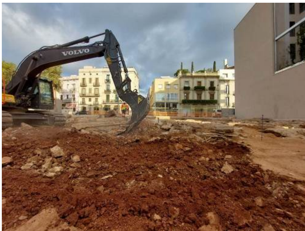
Foto 324: Eliminacions finca 4 soterrani.
