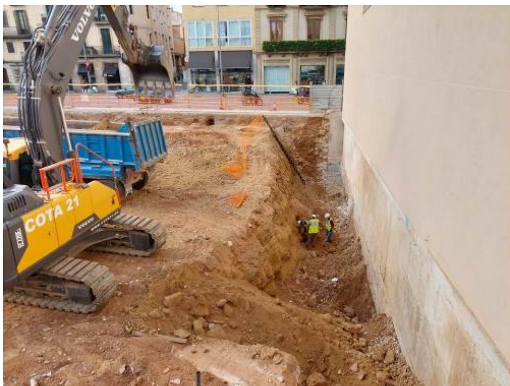
Foto 358: Neteja de la mina 8002.
