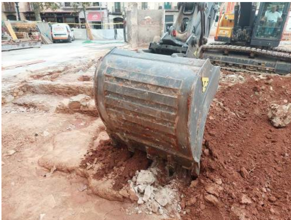
Foto 319: Eliminacions finca 1, murs 1009 i 1019.
