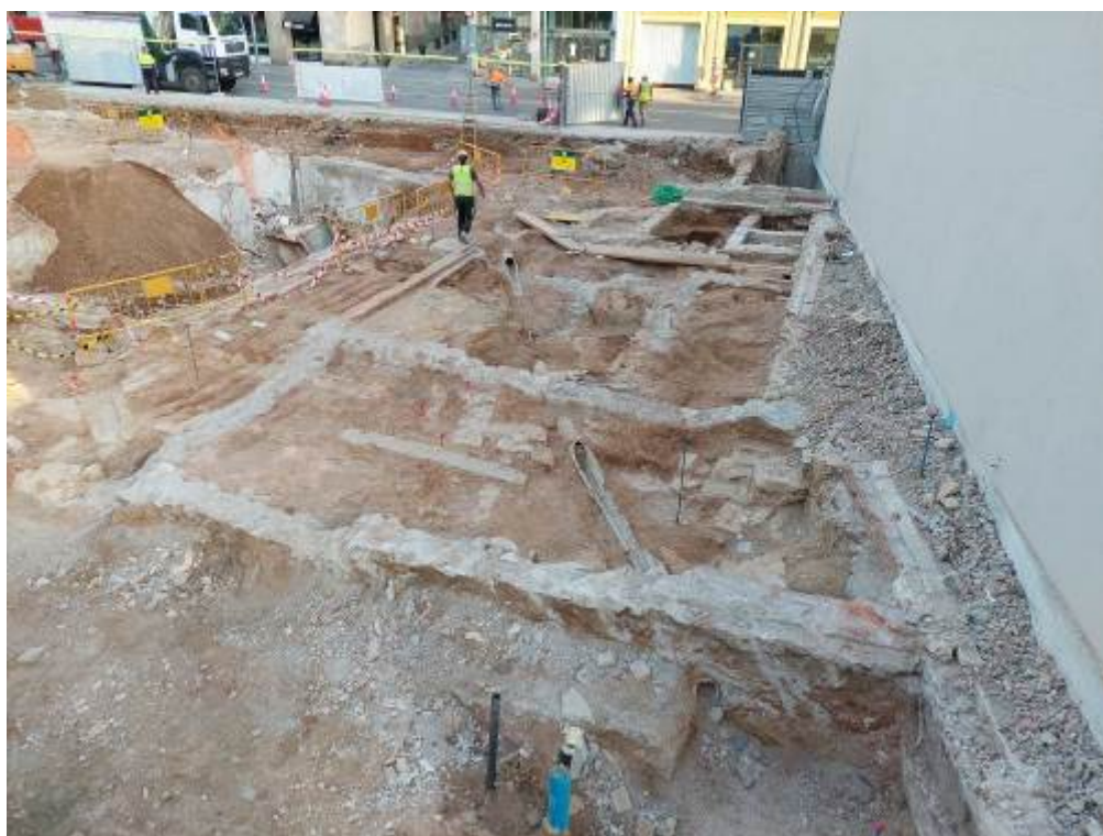
Foto 18: Inici d'excavació manual.
