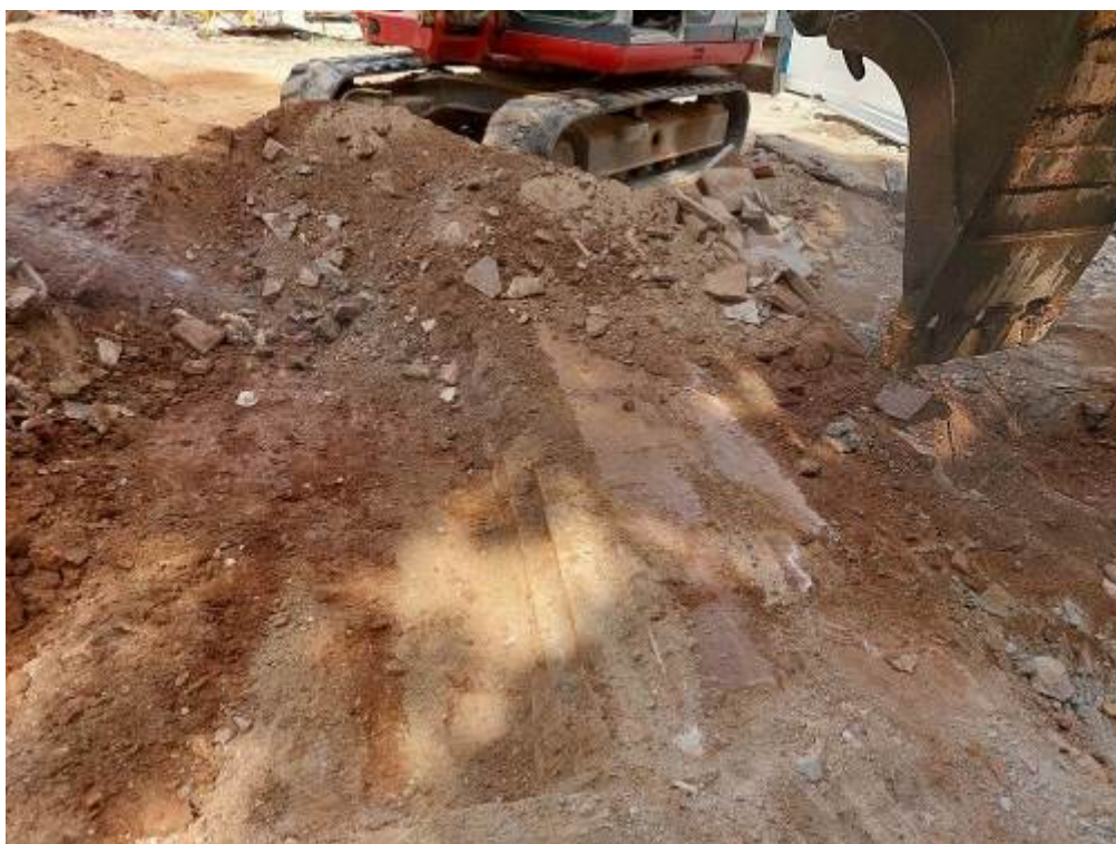
Foto 10: Extracció del paviment actual.
