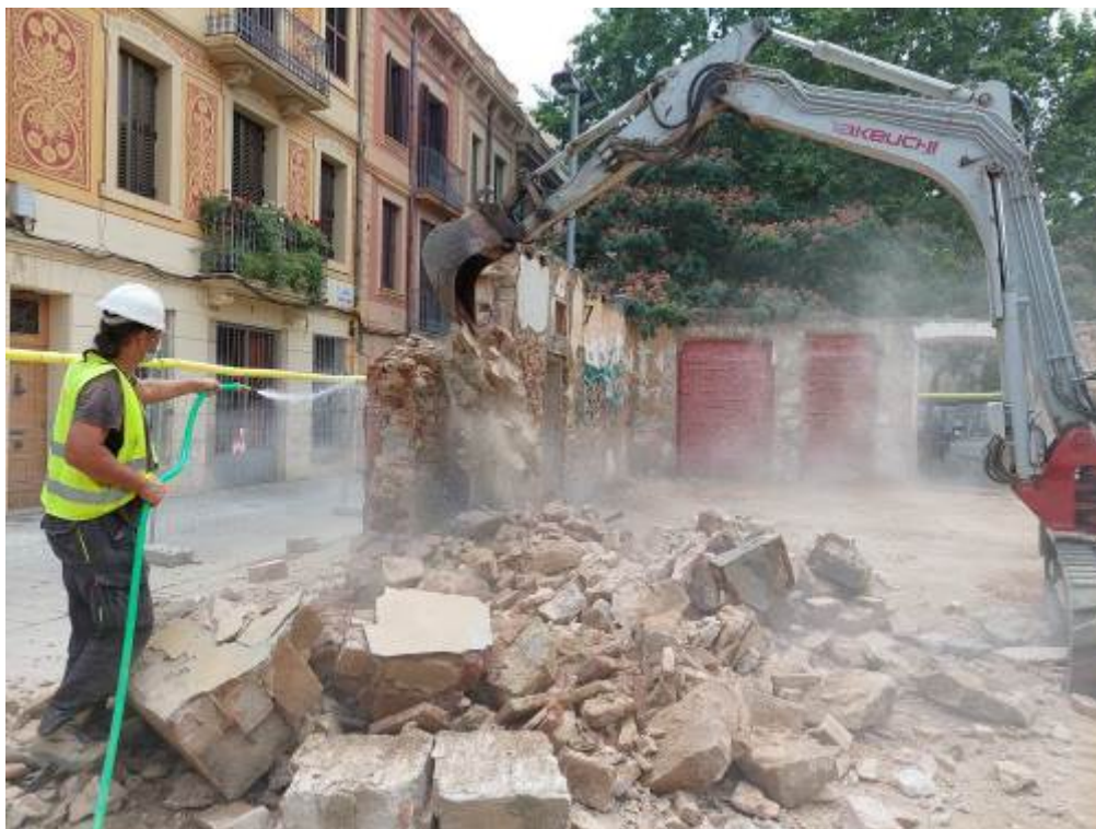
Foto 5: Eliminació d'estructures aèries encara dempeus.
