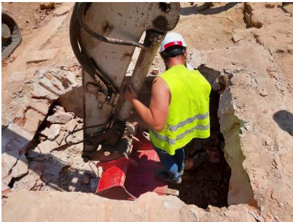
Foto 131: Eliminació controlada del registres dels cups 3003.
