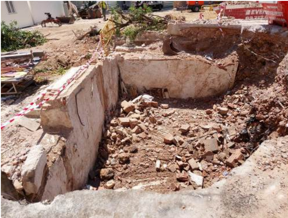
Foto 299: Soterrani finca 4 amb murs 1032 i 4003.
