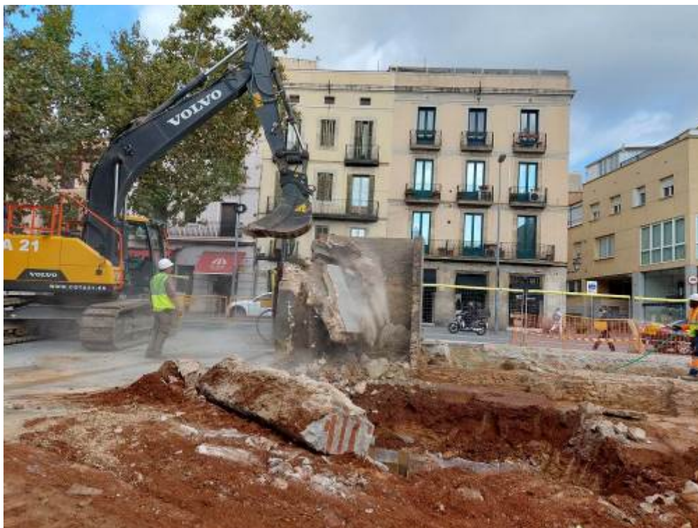
Foto 333: Eliminacions finca 3 murs 1003, 3017 i 3018.
