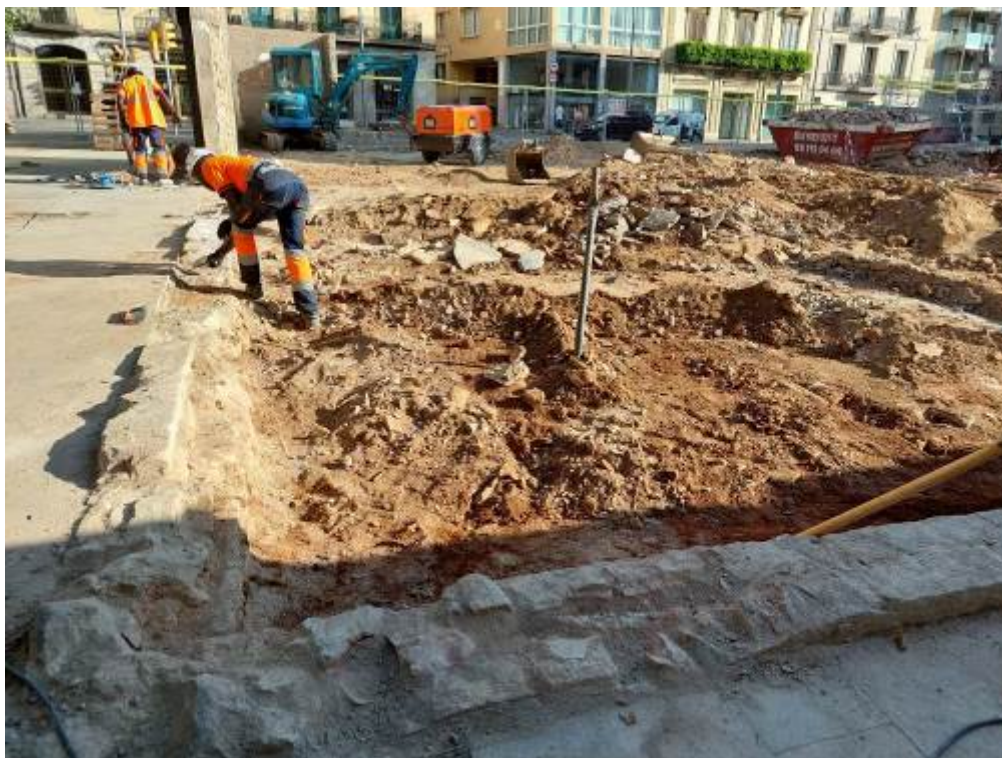
Foto 11: Inici del moviments de terres i localització d'estructures.
