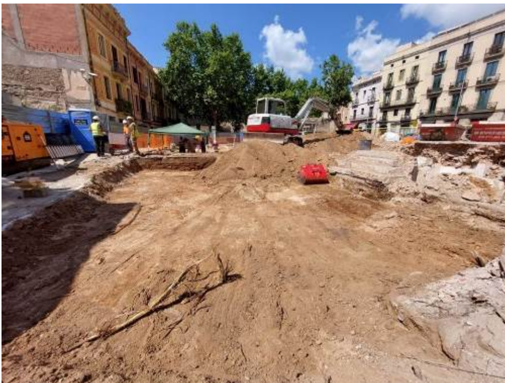
Foto 14: Inici del moviments de terres i localització d'estructures.
