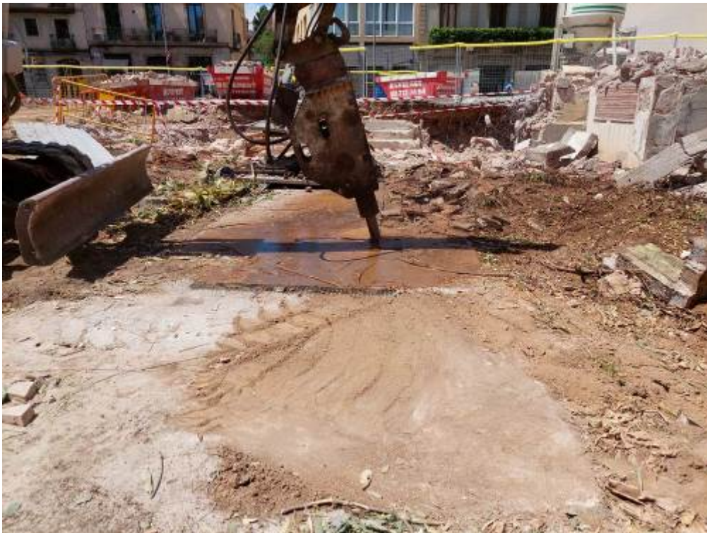
Foto 8: Extracció del paviment actual.
