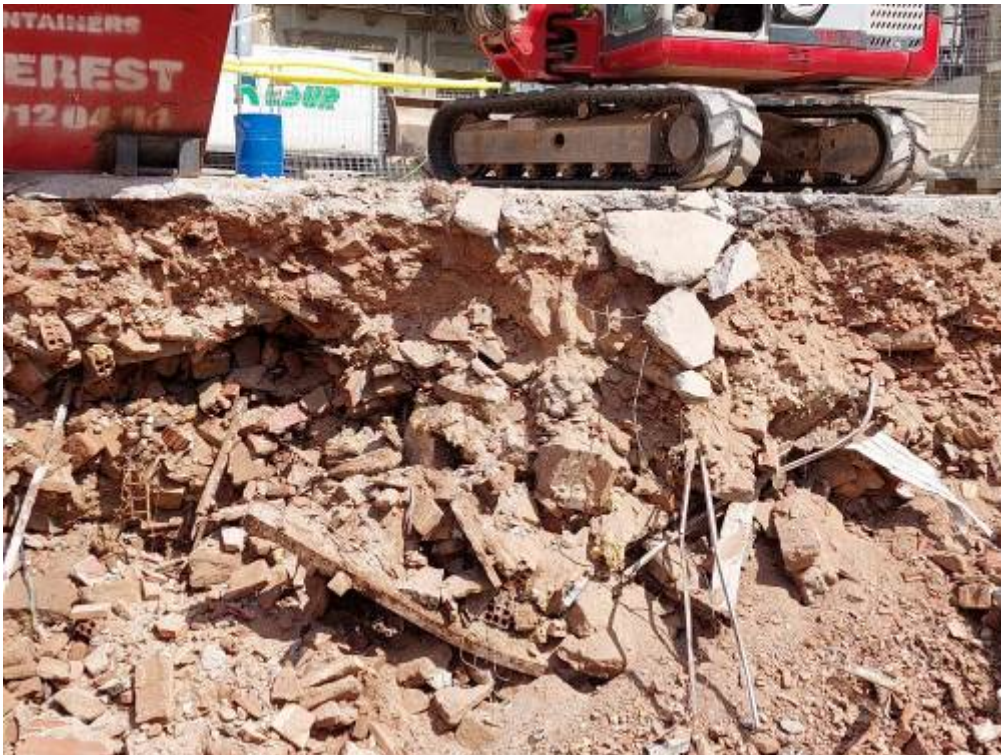
Foto 300: Detall del farciment del soterrani 4022.
