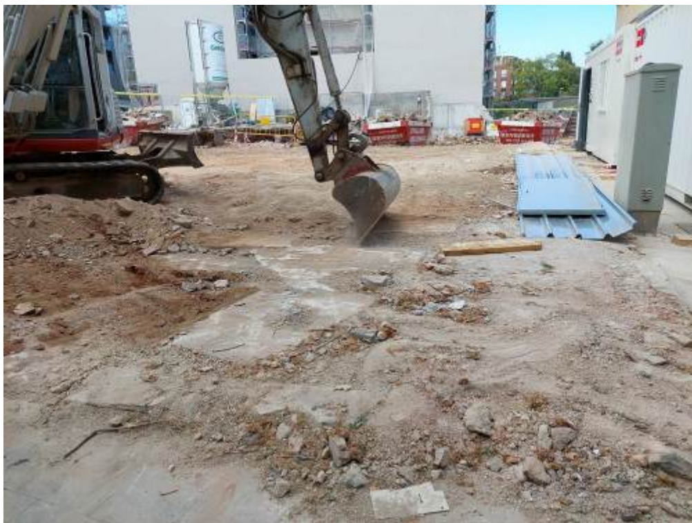
Foto 9: Extracció del paviment actual.
