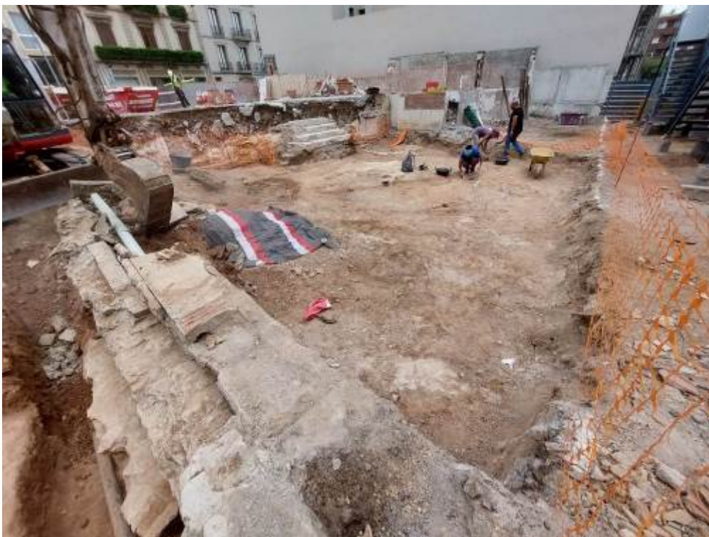
Foto 144: Tasques d'excavació mecànica.
