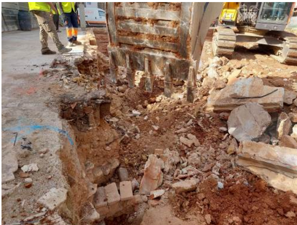
Foto 335: Eliminacions finca 1 murs 1003, 1004, 1013.
