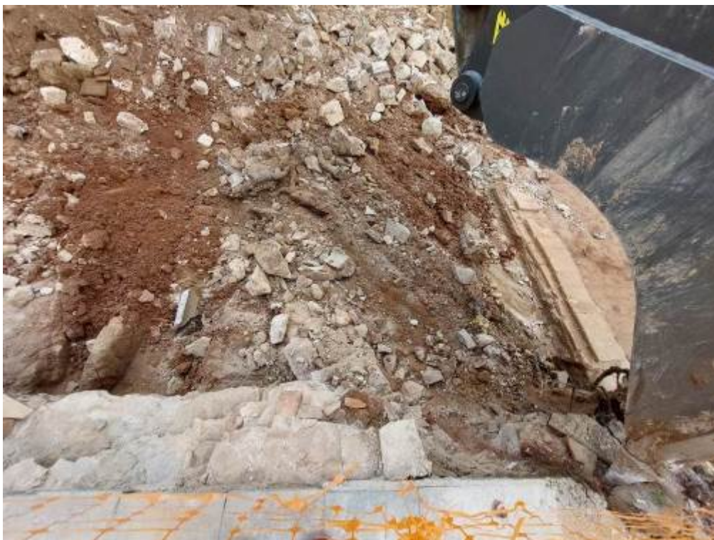
Foto 321: Eliminacions finca 1, murs 1009 i 1019.
