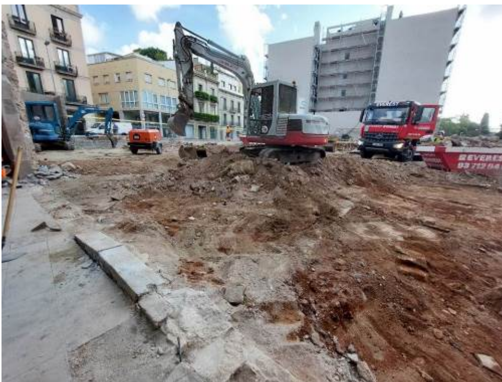
Foto 12: Inici del moviments de terres i localització d'estructures.
