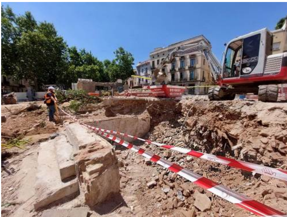
Foto 298: Soterrani finca 4 amb escales 4004.
