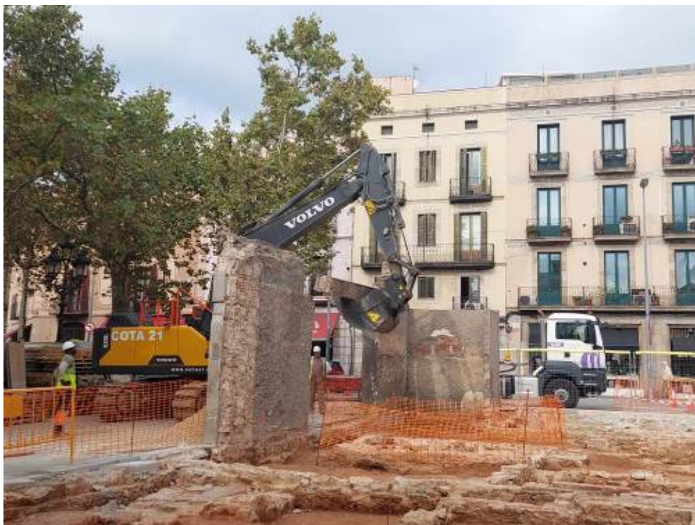
Foto 309: Eliminació de les porcions del mur 1003 que restaven.
