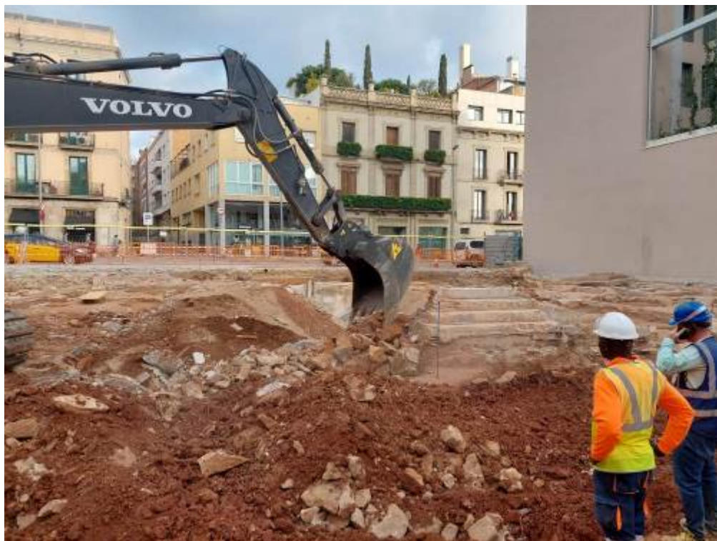
Foto 323: Eliminacions finca 4 soterrani.
