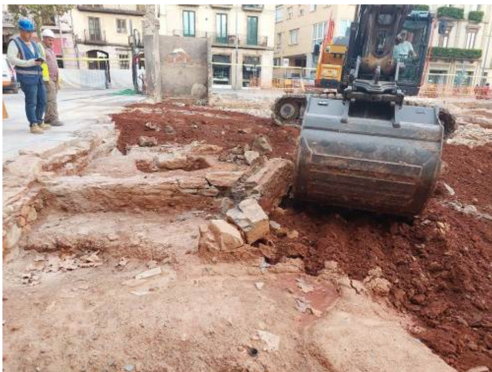
Foto 320: Eliminacions finca 1, murs 1009 i 1019.
