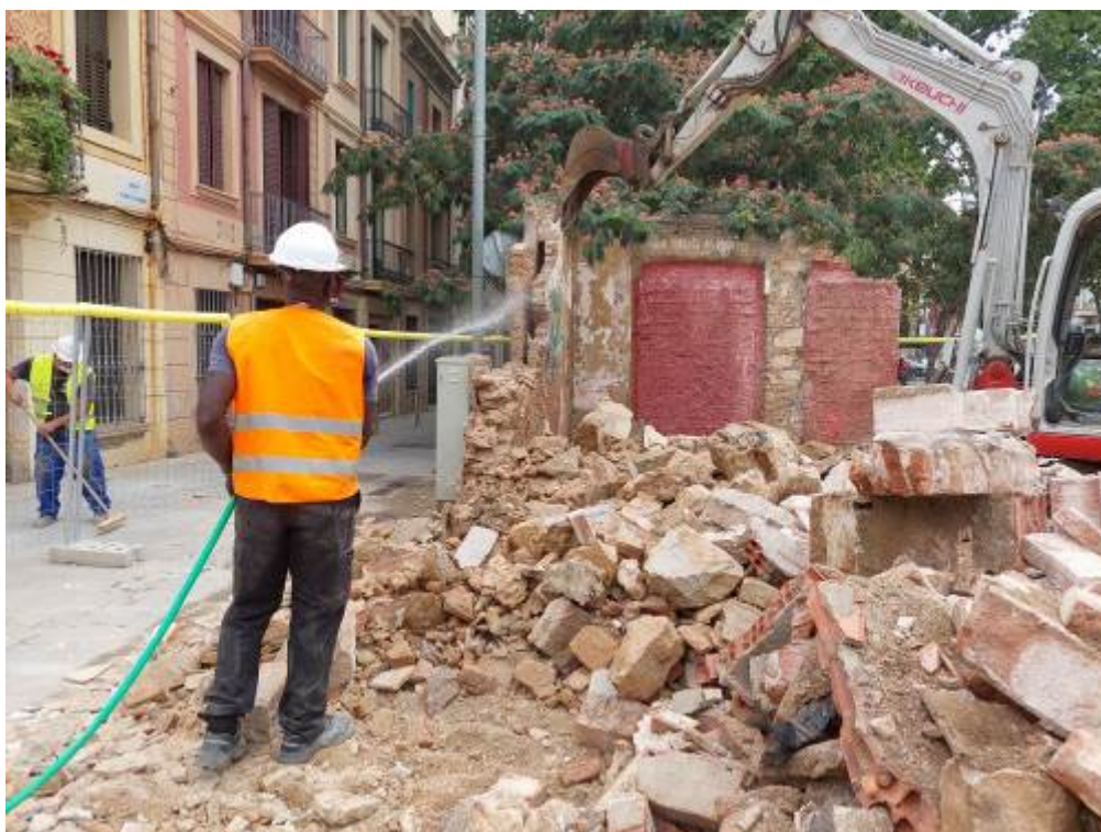
Foto 6: Eliminació d'estructures aèries encara dempeus.
