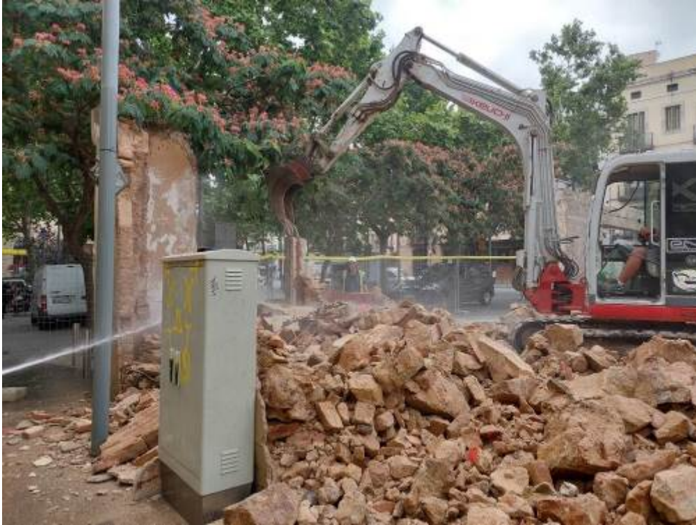
Foto 7: Eliminació d'estructures aèries encara dempeus.
