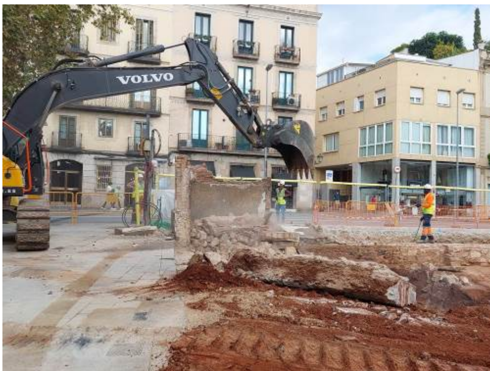
Foto 334: Eliminacions finca 3 murs 1003, 3017 i 3018.
