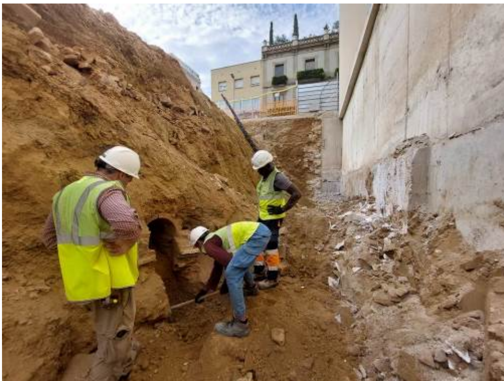
Foto 357: Neteja de la mina 8002.
