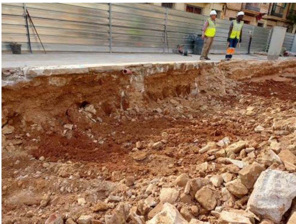
Foto 336: Perfil S de la finca després d'eliminació 1004, 1009 i 1030
