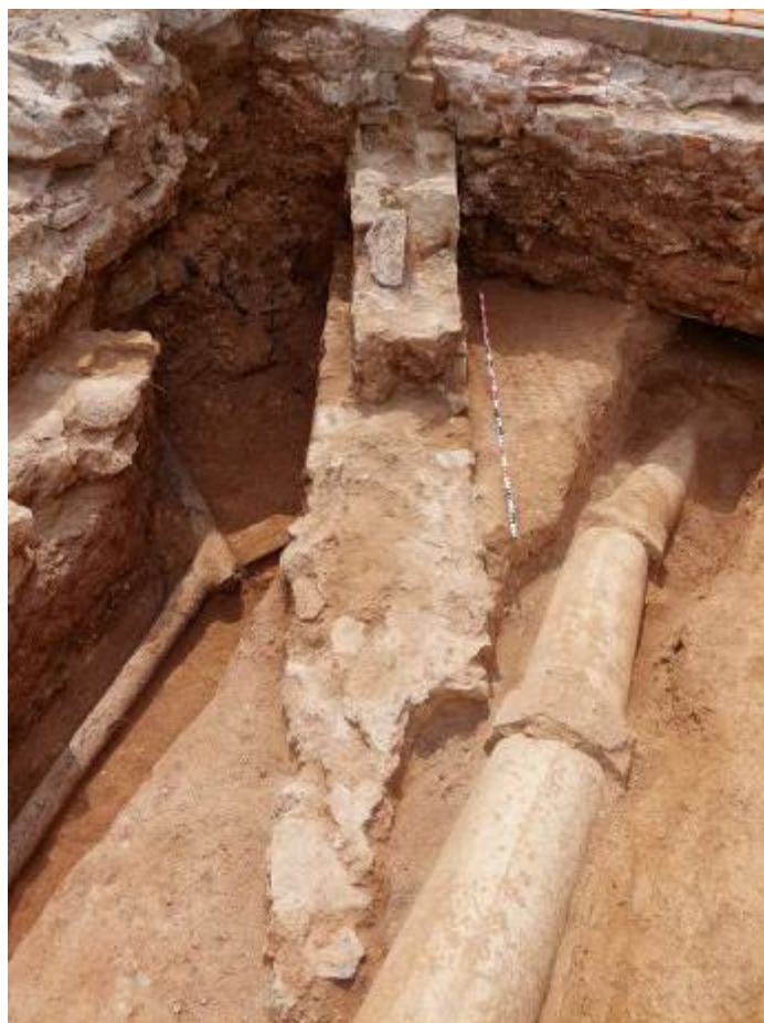
Foto 33: Mur 1037 trencat per la canalització 1033.
