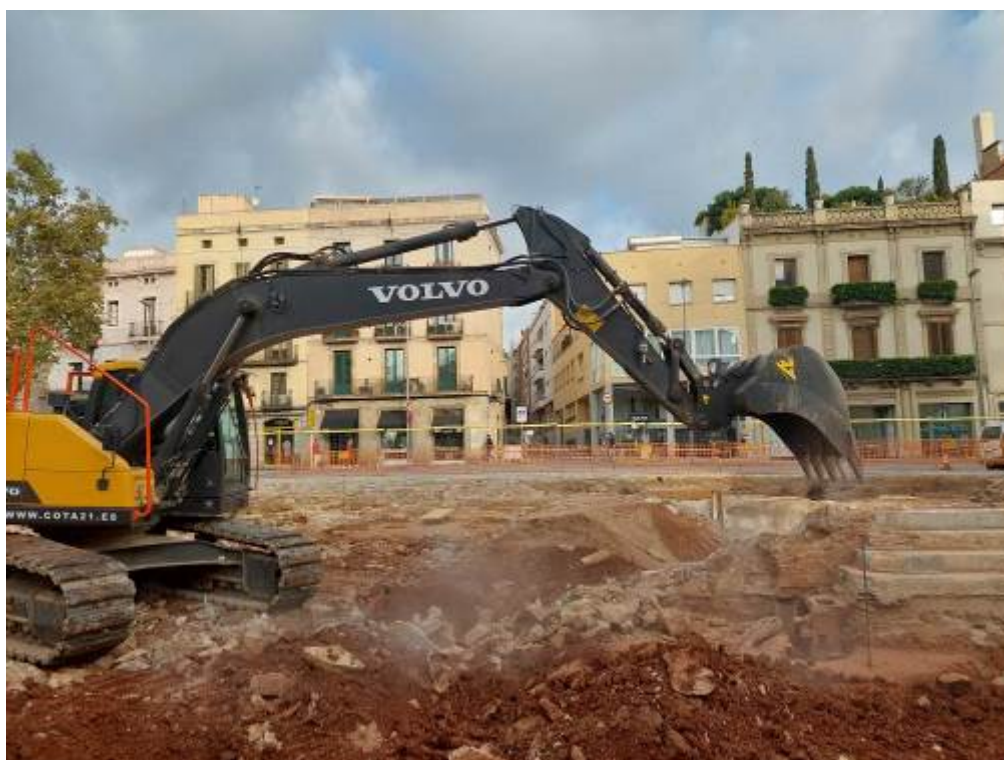
Foto 322: Eliminacions finca 4 soterrani.
