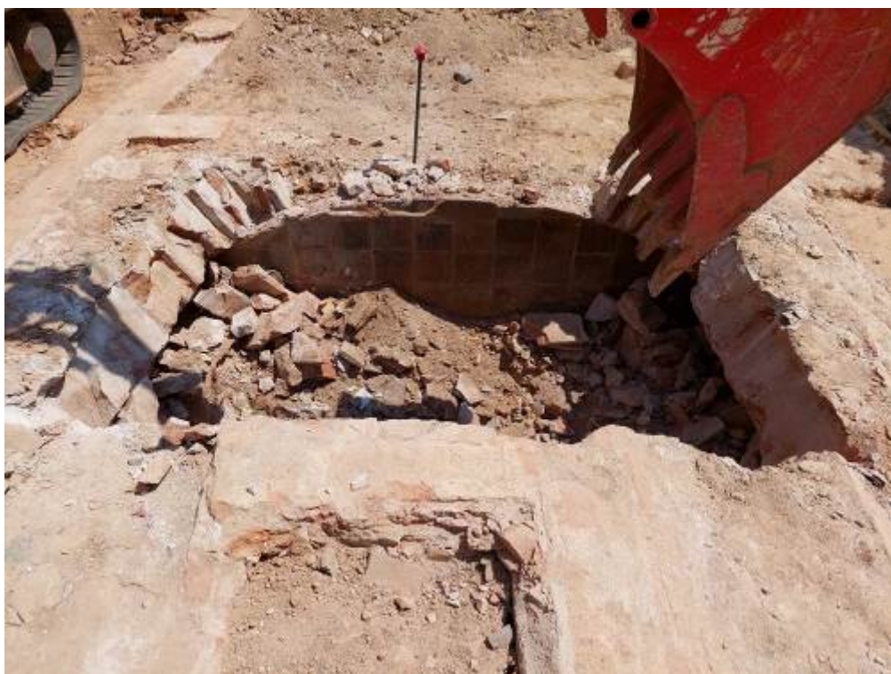
Foto 130: Eliminació controlada del registres dels cups 3003.
