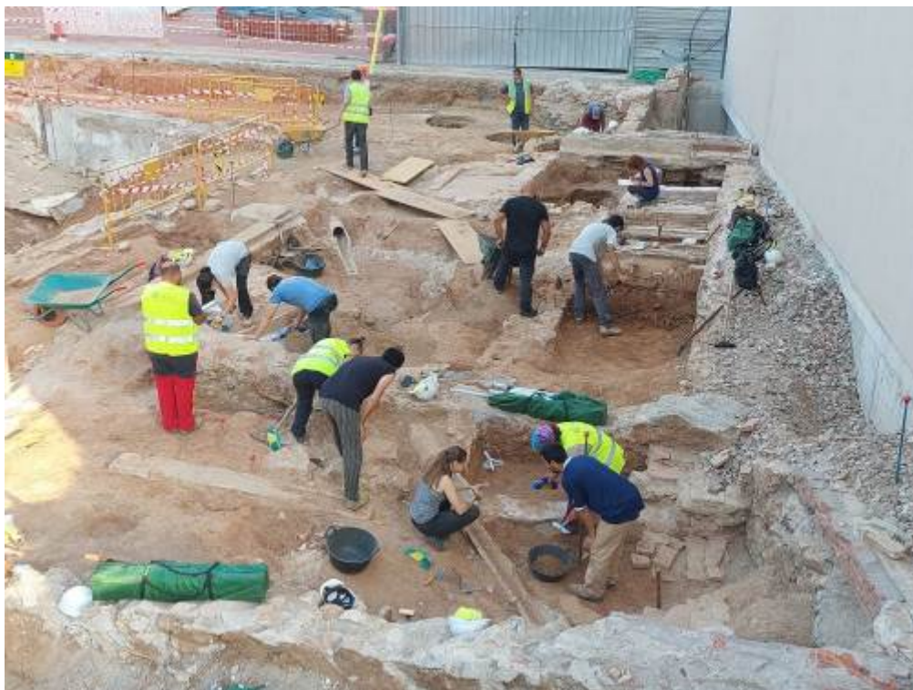
Foto 19: Inici d'excavació manual.
